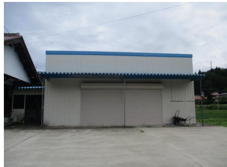
倉庫 外観 南側
