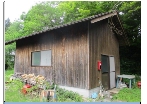
倉庫 外観 南東側
