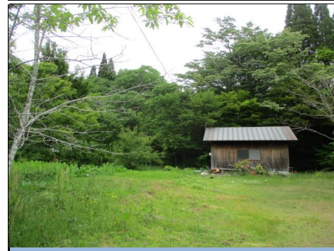
倉庫 外観 南側
