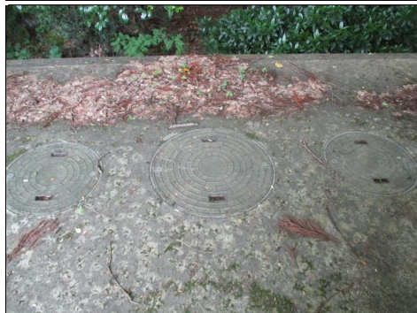
浄化槽設置状況
