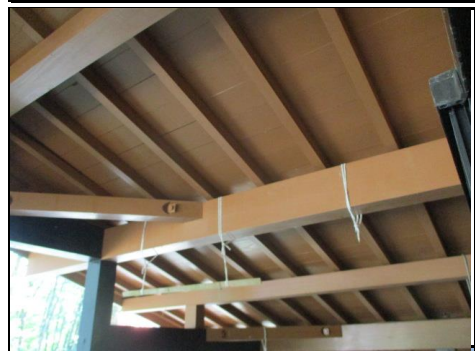
ウッドデッキ屋根
