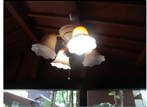
ウッドデッキ照明
