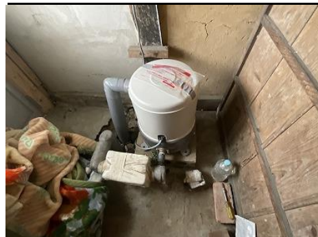
井戸ポンプ設置状況
