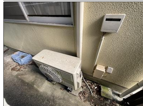
エアコン室外機設置状況
