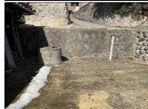
井戸設置状況
