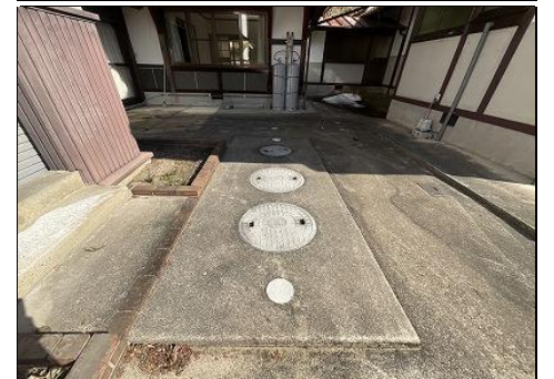
浄化槽設置状況
