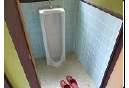
トイレ小便器
