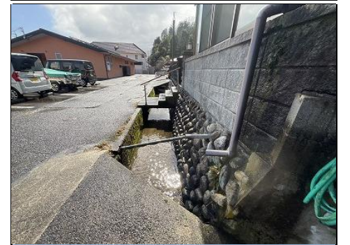
側溝 接道状況
