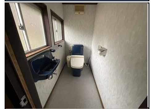
1階トイレ水洗
