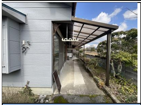
外観東側 物干し場
