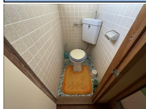
2階トイレ水洗
