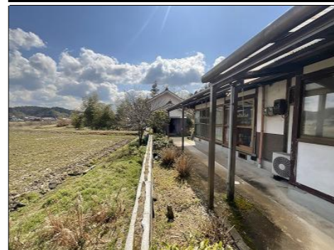
主屋外観 東側
