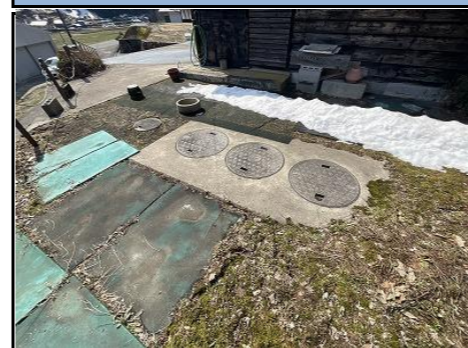
浄化槽設置状況
