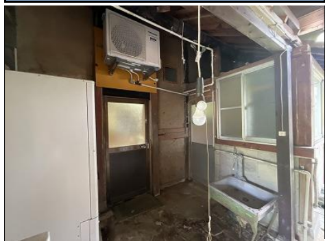
エアコン室外機取付状況
