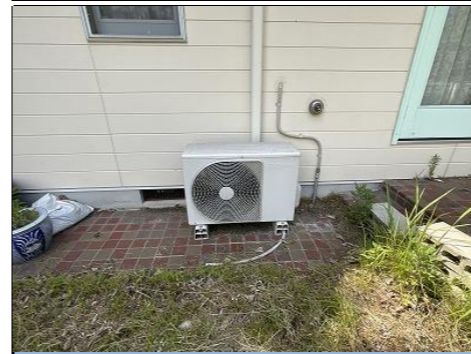
室外機設置状況
