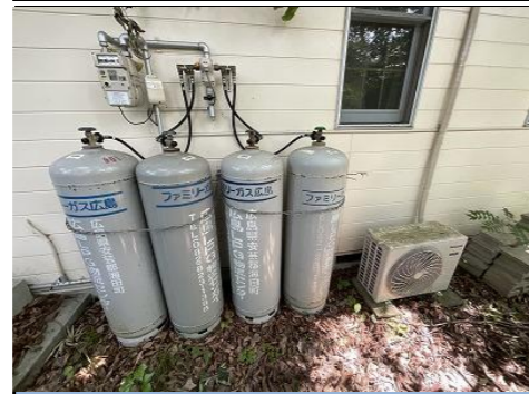
ガスボンベ設置状況 北側
