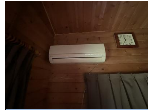
エアコン設置状況
