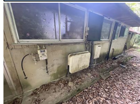
外観 北側 給湯器
