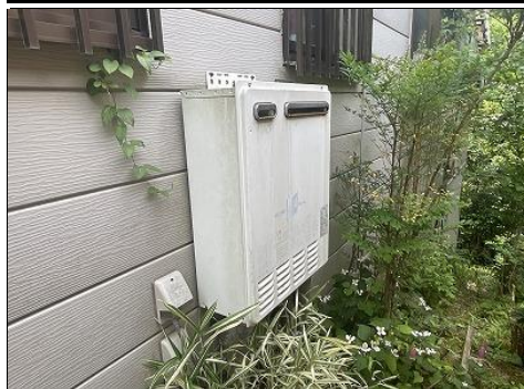
ガス給湯器設置状況
