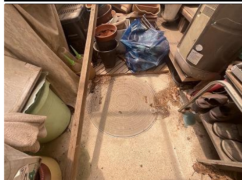
浄化槽設置状況
