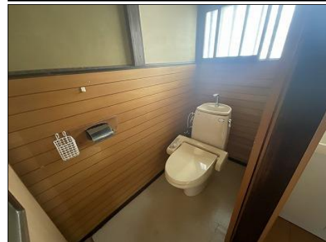
トイレ 浄化槽
